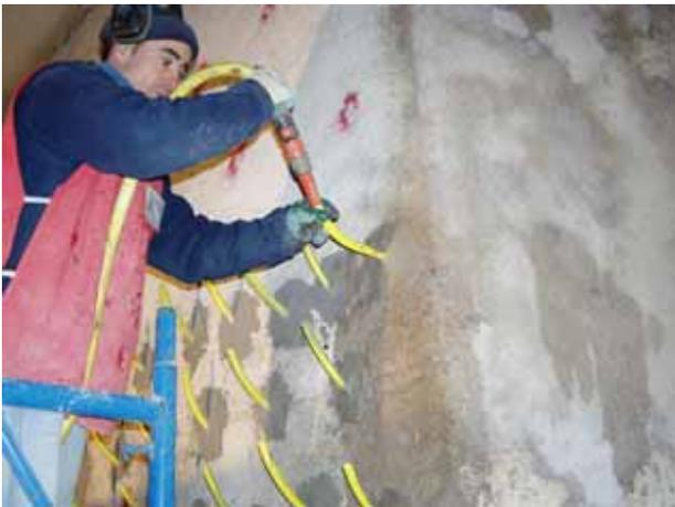
Prima di iniziare l'iniezione, quando è possibile, si consiglia il lavaggio della massa muraria da iniettare mediante acqua a bassa pressione (massimo 1 atm all'ugello) introdotta a partire dai fori più alti. Il lavaggio consente una ottimale penetrazione della boiaccia da iniezione.
