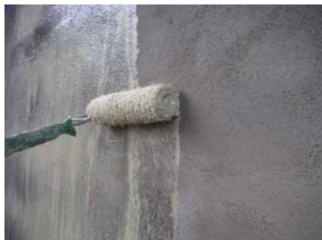
Dopo l'applicazione del primer sarà necessario attendere un tempo minimo di 6 ore e massimo di 48 ore, in condizioni ambientali standard (20°C, 65 % UR), per procedere con l'applicazione della finitura MASTERSEAL 120.
