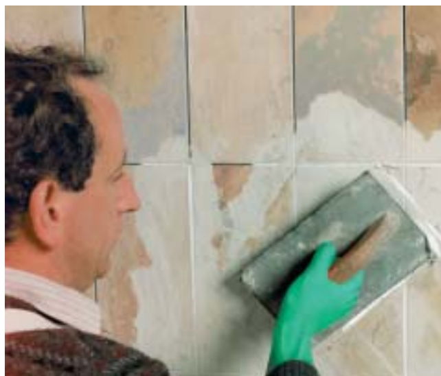
Stuccatura di marmo e pietre naturali nobili con stucchi esenti di sabbie quarzifere.
