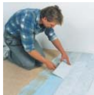
Con l'adesivo speciale PCI-Collastic si può posare anche il marmo su pannelli in truciolare.
