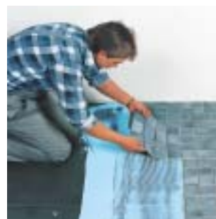
Posa di piastrelle e lastre nel letto di collante steso.
