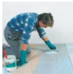
PCI-Collastic è indicato su supporti sensibili all'umidità come per esempio pannelli in truciolare compensato.
