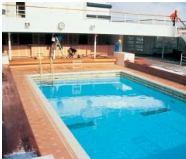
Piastrelle posate con PCI-Collastic su un ponte di una nave.
