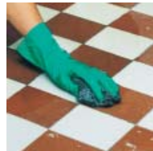
Pulire il sottofondo con un detergente idoneo (PCI-Univerdünger) da resti che impedirebbero l'adesione.
