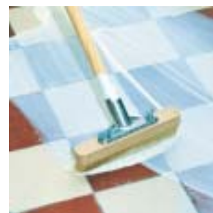
Applicare il primer in modo uniforme stendendolo incrociato sul sottofondo.
