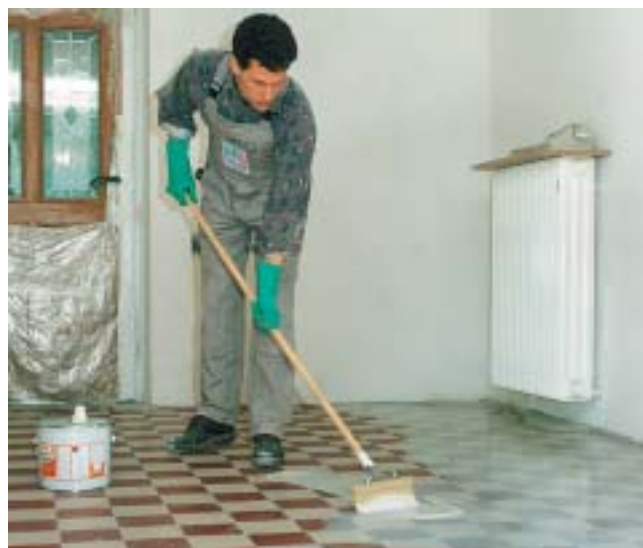
PCI-Flächengrund 303 e il primer d'aggancio sicuro per la posa sicura di rivestimenti su piastrelle e lastre in ceramica.
