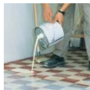
Scuotere bene PCI-Flächengrund 303 e versare sul sottofondo.
