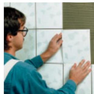
Ai muri, con l'adesivo PCI-FT-Plus, le piastrelle vengono applicate senza essere coniate.
