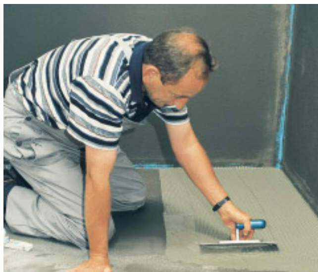
Adesivi miscelati con PCI-Lastoflex compensano tensioni del sottofondo e degli sbalzi di temperatura.
