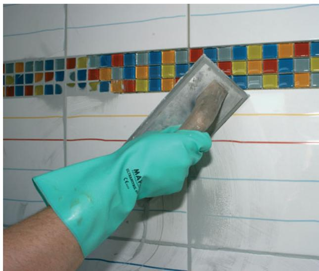
Applicazione comoda e indipendente dalla temperatura – con PCI Nanofug il riempimento dei giunti risulta facile e omogeneo.
