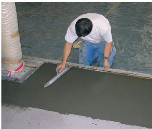
PCI Novoment M1 plus è una malta pronta a presa rapida e rappresenta una soluzione economica e molto pratica per la messa in opera di piccole superfici e di settori di massetto che devono essere utilizzati entro breve tempo.
