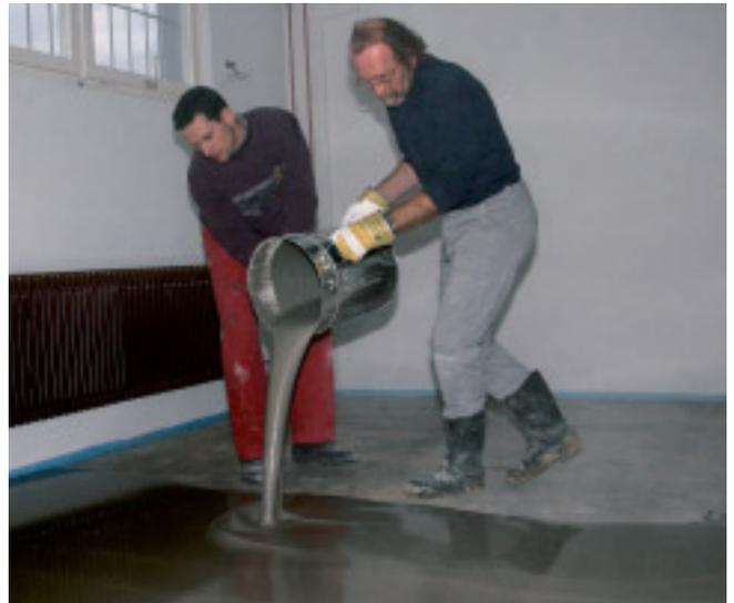
Livellare pavimenti in modo razionale e redditizio con PCI-Periplan prima della posa di rivestimenti.
