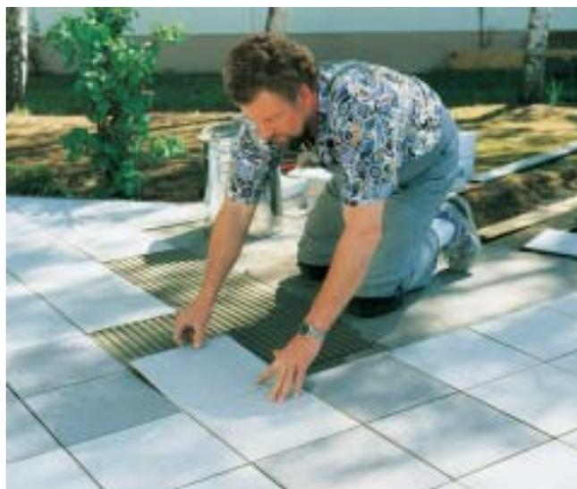
PCI-Polyflott-Schnell non è indicato solo per la posa senza vuoti d'aria, ma anche per livellare sottofondi irregolari da 4 a 15 mm prima della posa rapida di piastrelle.
