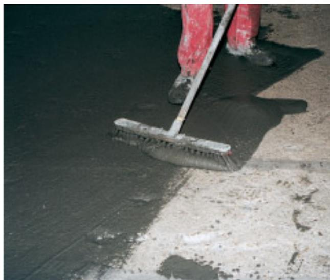
PCI-Repahaft viene steso spazzolando sul sottofondo. Applicare il massetto sul ponte d'aggancio ancora fresco.
