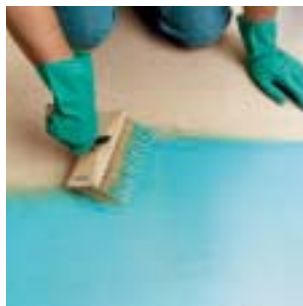
1. Applicare PCI-Wadian in modo incrociato sul sottofondo.
