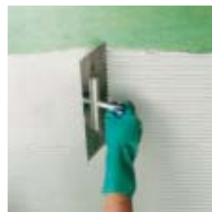
4. Parete: Dopo l'essiccazione (ca. 12 ore) possono essere eseguiti altri lavori come la posa di piastrelle con PCI-Bicollit. Stendere uno strato di contatto sottile al sottofondo e applicare con una spatola dentata l'adesivo.
