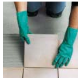
3. Pavimento: Dopo l'essiccazione dello strato di PCI-Wadian possono essere applicati PCI-Lastogum o PCI-Seccoral al pavimento. Su questo strato impermeabilizzante, una volta asciutto, si possono applicare piastrelle e lastre (vedi tabella).
