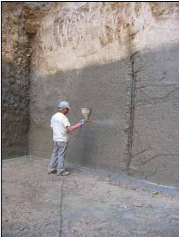
THOROSEAL CPB1 (OSMOTICO) è indicato perciò per la impermeabilizzazione ad esempio di dighe, serbatoi, scantinati, opere contro terra, strutture interrato, fondazioni, canali, gallerie, muri di sostegno, divenendo con essi un corpo unico.
