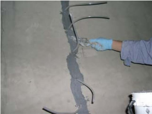
Quando le sigillature garantiscono la tenuta (dopo circa 24 ore) collegare la pompa al tubicino più basso e procedere all'iniezione aumentando gradatamente la pressione; la fuoriuscita di resina dal tubicino superiore indica il riempimento della fessurazione trattata.
