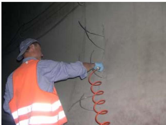
Eliminare le parti friabili ed incoerenti e spolverare accuratamente la superficie mediante aria compressa, fissare quindi dei tubicini di rame, con sezione di 8 mm nei fori, sigillare le fessurazioni e fissare i tubicini di iniezione con l'adesivo CONGRESIVE PASTA.
