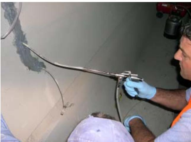
A questo punto chiudere il tubicino di entrata e ripetere le varie operazioni verso l'alto fino a completamento dei lavori. I valori relativi alla pressione di pompaggio devono essere valutati in cantiere in quanto possono variare a seconda delle dimensioni o della profondità della fessurazione. Non applicare il prodotto a temperature inferiori a 5°C in quanto il tempo di polimerizzazione risulterebbe estremamente allungato.
