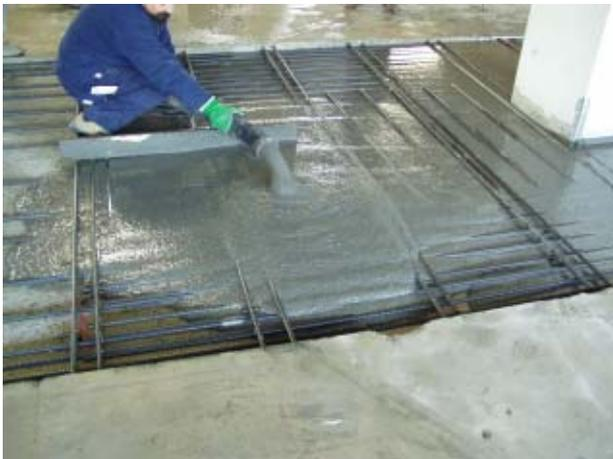
Può essere applicato per colaggio su calcestruzzi macroscopicamente irruviditi (asperità di circa 5 mm), in spessori d'intervento compresi tra 1 e 5 cm. Per interventi di spessore 3 - 5 cm l' EMACO FORMULA REODINAMICO M1 deve essere utilizzato solo previa applicazione di armatura di contrasto, per interventi di tale spessore si consiglia tuttavia l'utilizzo di EMACO FORMULA FLOWFIBER il quale non necessita dell'ausilio della rete elettrosaldata.
