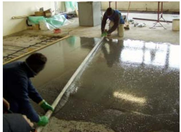
Per i getti eseguiti entro cassero il collaggio della malta va eseguito con continuità e solo da un lato per favorire la fuoriuscita dell'aria. La sua particolare reologia gli consente di autocompattarsi senza necessità di vibrazione e di scorrere anche in strutture fortemente armate e/o a geometria complessa. Per interventi di spessore superiore a 5 cm si dovrà utilizzare l'EMACO FORMULA REODINAMICO B1.
