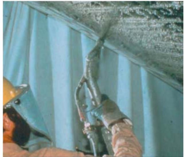
Può essere messo in opera a cazzuola (piccole superfici) o mediante macchine spruzzatrici (superfici estese) a coclea o a pistone (non a ciclo continuo). Durante le fasi di interruzione dello spruzzo (in funzione anche della temperatura esterna) è necessario prevedere l'accurata pulizia delle tubazioni e della pompa stessa mediante acqua in pressione e palla di gomma morbida pulisci tubi.
