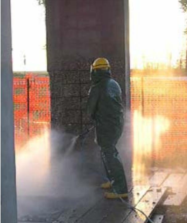
L'asportazione del calcestruzzo incoerente o contaminato deve avvenire mediante idrodemolizione o con scalpellatura meccanica eseguita con demolitori leggeri alimentati ad aria compressa, adottando tutte le precauzioni necessarie per evitare il danneggiamento delle strutture.
