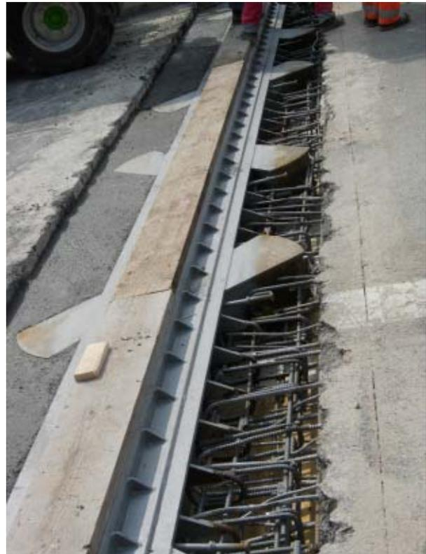
Per interventi di spessore superiore a 5 cm è necessario aggiungere all'impasto dell'aggregato lavato, privo di impurità, avente diametro minimo superiore a 5 mm e diametro massimo in funzione dello spessore del getto, in quantità pari al 35% sul peso totale della miscela secca.
