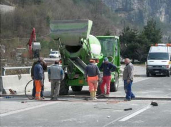
L'uso del componente B consente anche un maggiore mantenimento di lavorabilità in clima estivo. Quando la temperatura risulta essere compresa tra i 5 e i 10° C è possibile adottare un dosaggio di componente B inferiore all'1% per evitare di rallentare eccessivamente i tempi di indurimento del prodotto.
