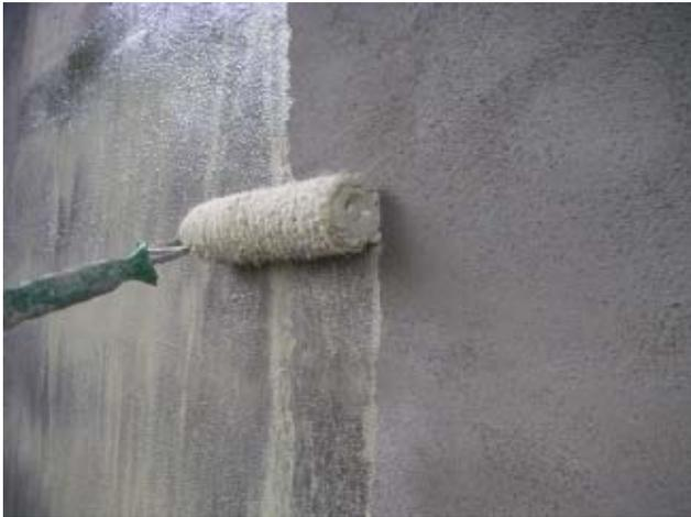
Dopo l'applicazione del primer sarà necessario attendere un tempo minimo di 6 ore e massimo di 48 ore, in condizioni ambientali standard (20°C, 65 % UR), per procedere con l'applicazione della finitura MASTERSEAL 110.
