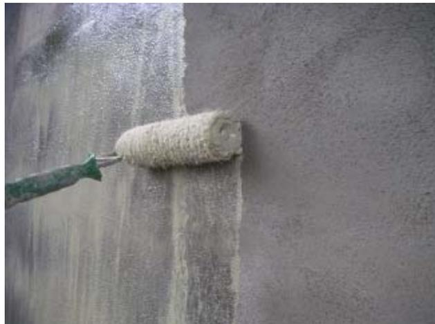
Dopo l'applicazione del primer sarà necessario attendere un tempo minimo di 6 ore e massimo di 48 ore, in condizioni ambientali standard (20°C, 65 % UR), per procedere con l'applicazione della finitura MASTERSEAL 135.
