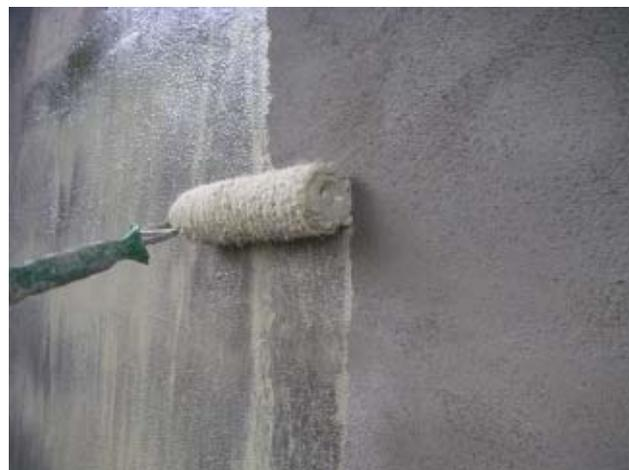
Dopo l'applicazione del primer sarà necessario attendere un tempo minimo di 6 ore e massimo di 48 ore, in condizioni ambientali standard (20°C, 65 % UR), per procedere con l'applicazione della finitura MASTERSEAL FORMULA PU.
