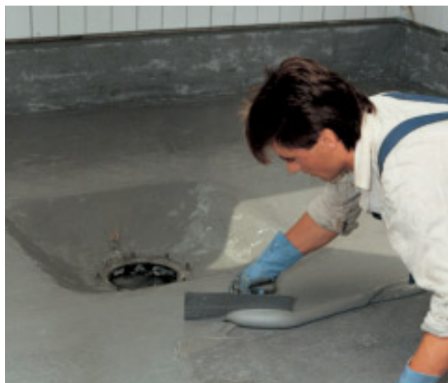
Applicazione del prodotto PCI-Apoflex TF Boden per impermeabilizzazione sottoposa di rivestimento ceramico in una grande cucina.
