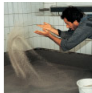
... quindi, a rivestimento ancora fresco, si procede a uno spolvero a base di sabbia di quarzo (granulometria 0,4 - 0,7 mm).
