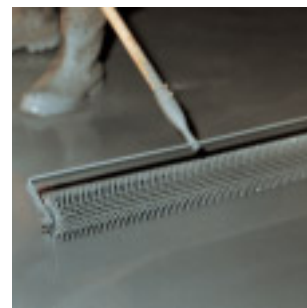
Una volta distribuito, PCI-Apoflex TF Boden viene rullato con un cilindro dentato.
