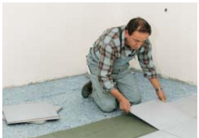
Incollaggio di un rivestimento ceramico con PCI-Everflex su PCI-Polysilent.
