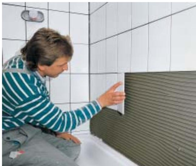
Con PCI-FT-Extra possono essere incollate in modo sicuro piastrelle in monocottura sulla impermeabilizzazione PCI-Lastogum.
