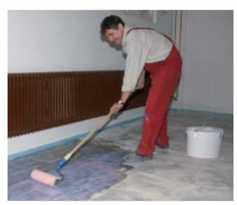
Applicare in modo uniforme con rullo in gomma a pori fini PCI-Gisofix NT sul sottofondo minerale. Dopo l'essiccazionesi possono eseguire subito i lavori successivi
