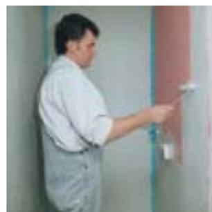
5. Dopo un tempo di asciugatura di una ora applicare la seconda mano protettiva con PCI-Lastogum (grigio). Evitare che la prima mano di PCI-Lastogum (rosso) sia visibile in trasparenza.
