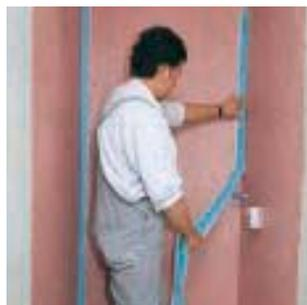
3. Integrare il nastro sigillante „PCI-Sicherheits-Dichtband-120“ nei giunti d'angolo e nei raccordi pavimento-pareti e incollarlo con PCI-Lastogum (rosso).
