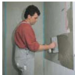
6. Dopo l'essiccamento della membrana impermeabile PCI-Lastogum è possibile procedere alla posa delle piastrelle con PCI-Flexmörtel.
