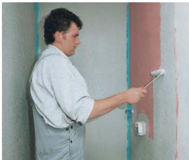
PCI-Lastogum viene applicato non diluito a rullo, a pennello o a spatola sul sottofondo.
