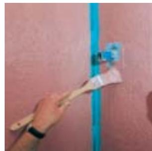
4. Applicare l'elemento sigillante „PCI-Sicherheitsdichtmanschette/Wand“ sui tubi di raccordo sporgenti dalle pareti e incollarlo con PCI-Lastogum (rosso).
