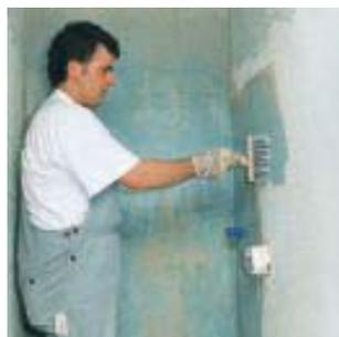
1. Pretrattare i sottofondi assorbenti, minerali o contenenti gesso e i pannelli in cartongesso con PCI-Giso-grund.
