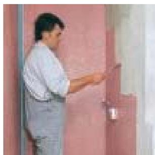
2. Applicare la prima mano protettiva di PCI-Lastogum (rosso) non diluito in modo uniforme e continuo sul sottofondo.
