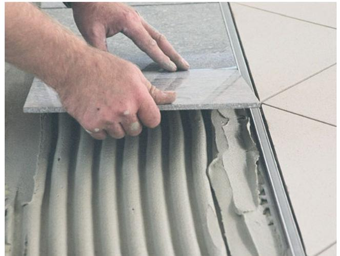
PCI Nanoflott flex è utilizzabile come adesivo autobagnante o come adesivo a strato sottile convenzionale.
