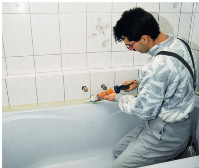
Sigillatura elastica di giunti con PCI Silcoferm VE; le tinte corrispondono a quelle delle malte cementizie per giunti.
